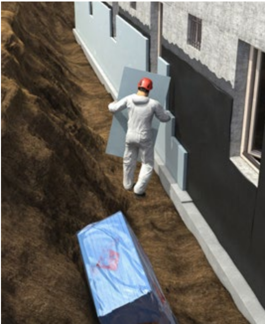
Abb. 91 Abdichtungsarbeiten am Kellergeschoss
