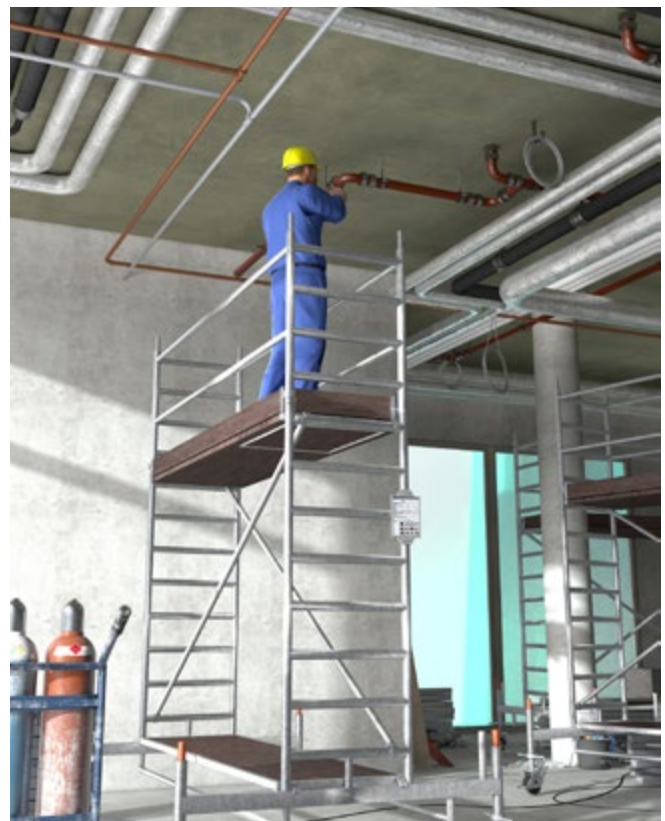
Abb. 3 Verwendung einer Fahrbaren Arbeitsbühne für Arbeiten an der Gebäudeinstallation
