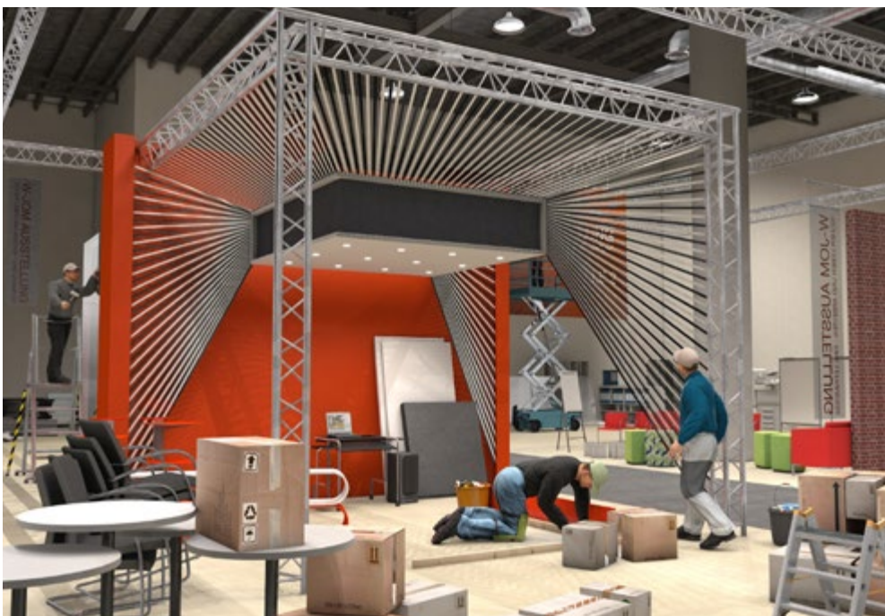
Abb. 97 Montage eines Messestandes
