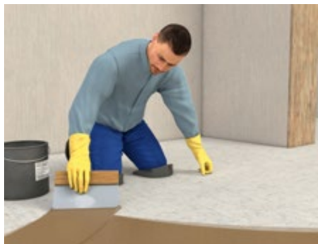
Abb. 94 Klebstoffauftrag mit Zahnspachtel
