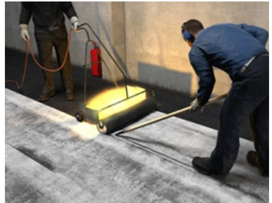
Abb. 90 Aufbringen von Schweißbahnen
