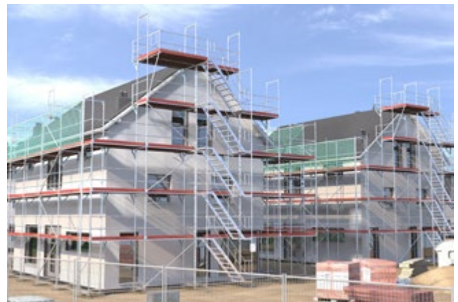
Abb. 60 Fachgerechter Zugang zum Gerüst
