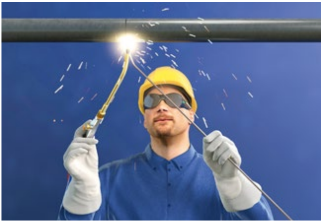
Abb. 26 Funkenflug bei Autogen-Schweißarbeiten
