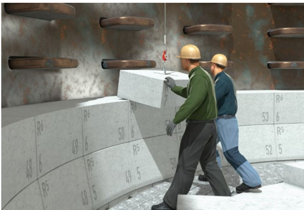
Abb. 137 Versetzen von Feuerfestfertigteilen im Hochofen
