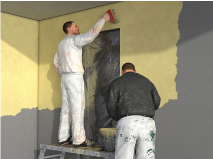
Abb. 130 Streichputzauftrag
