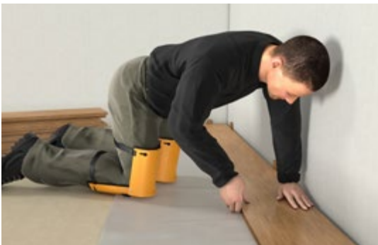
Abb. 93 Verlegen von Parkettboden
