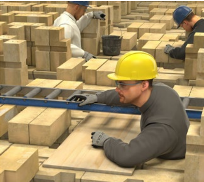
Abb. 135 Zustellung einer Koksofenbatterie
