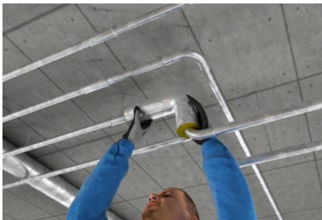
Abb. 151 Wärmeschutzisolierung
