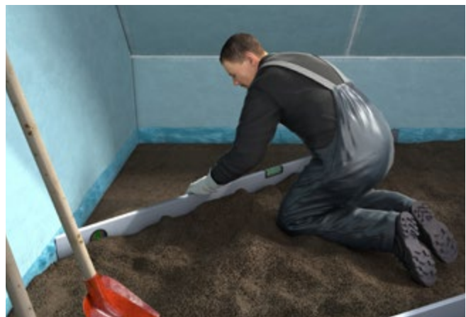
Abb. 106 Estricheinbau
