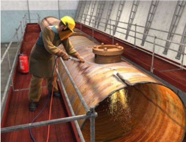
Abb. 114 Rückbau Rohranlage
