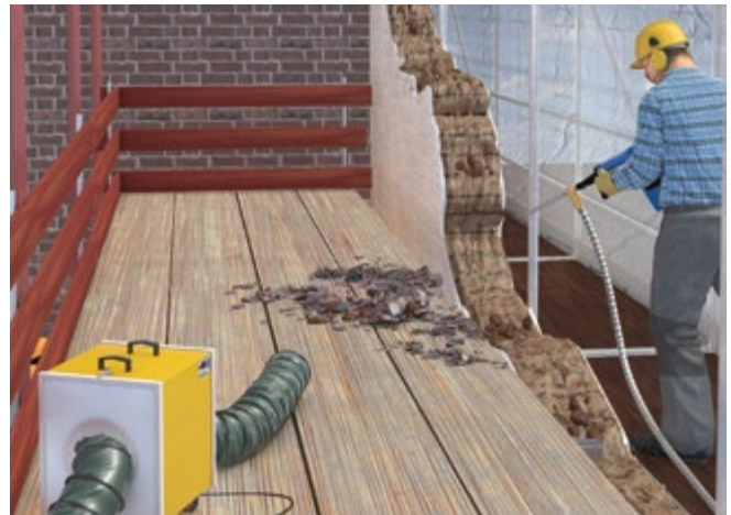
Abb. 4 Absturzsicherung durch Seitenschutz bzw. durch Fassadengerüst
