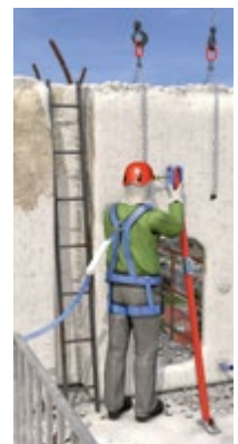
Abb. 110 Anschlagen eines Bauteils
