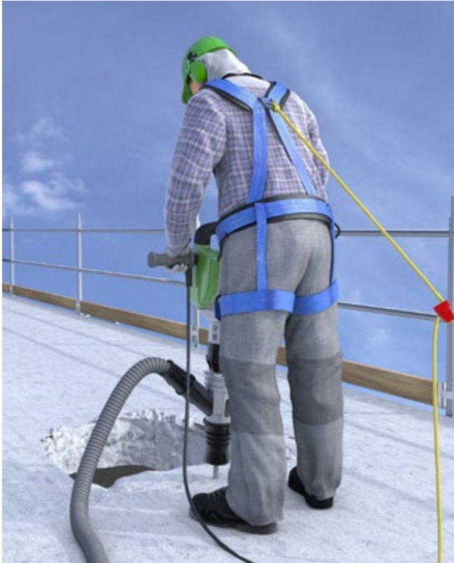
Abb. 101 Abbrucharbeiten mit PSaG
