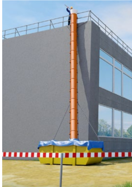
Abb. 103 Absturzsicherung an Schuttrutsche
