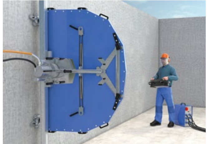
Abb. 105 Betonsägearbeiten
