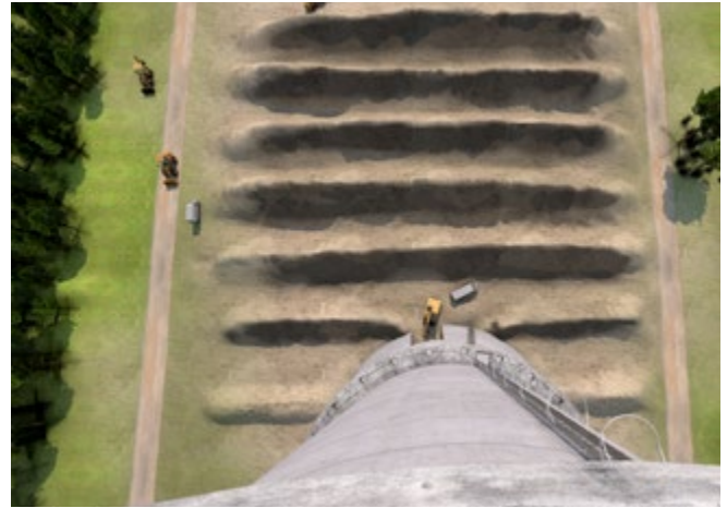
Abb. 119 Fallbett für eine Schornsteinsprengung
