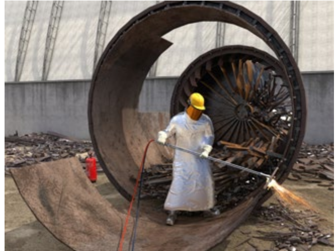
Abb. 115 Brennschneidarbeiten
