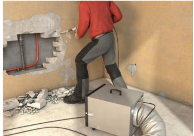
Abb. 12 Luftreiniger bei Stemmarbeiten
