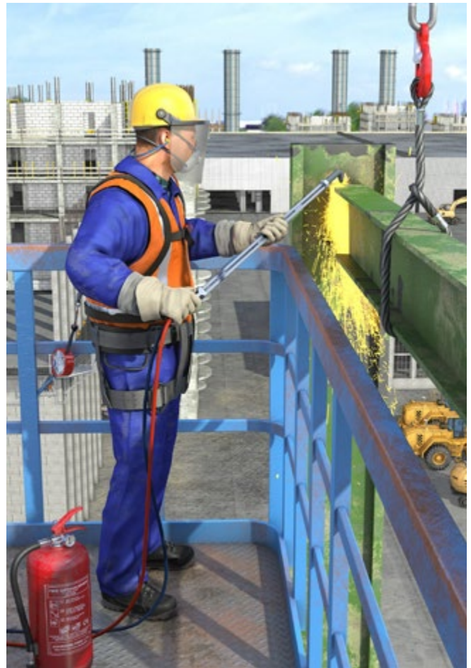
Abb. 25 Schneidbrennarbeiten
