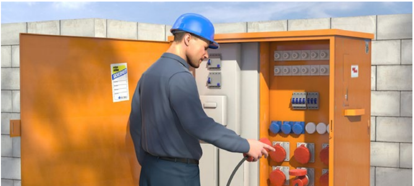
Abb. 20 Baustromverteiler zur sicheren Stromversorgung einer Baustelle
