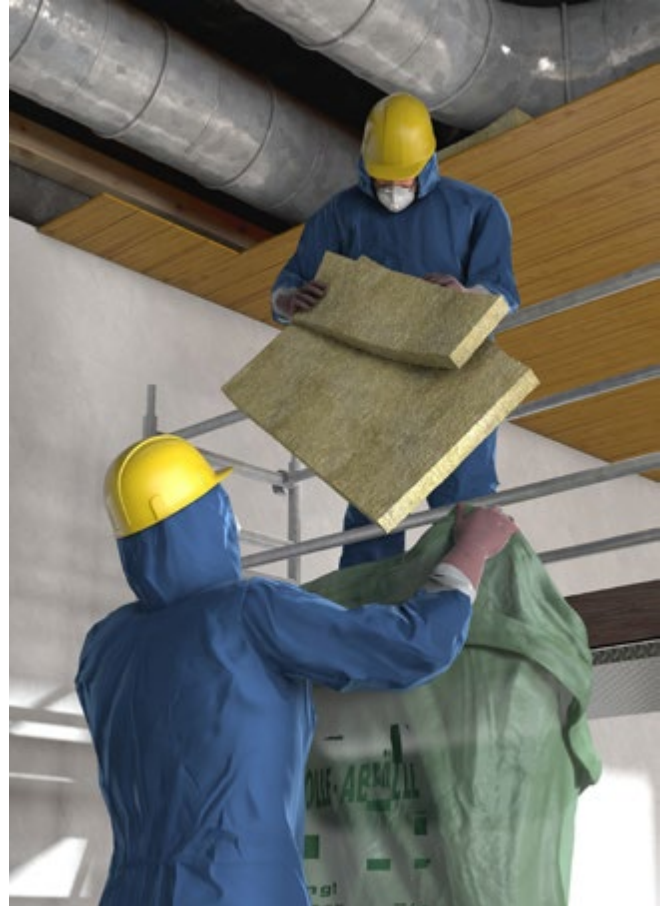
Abb. 11 Ausbau von Dämmplatten
