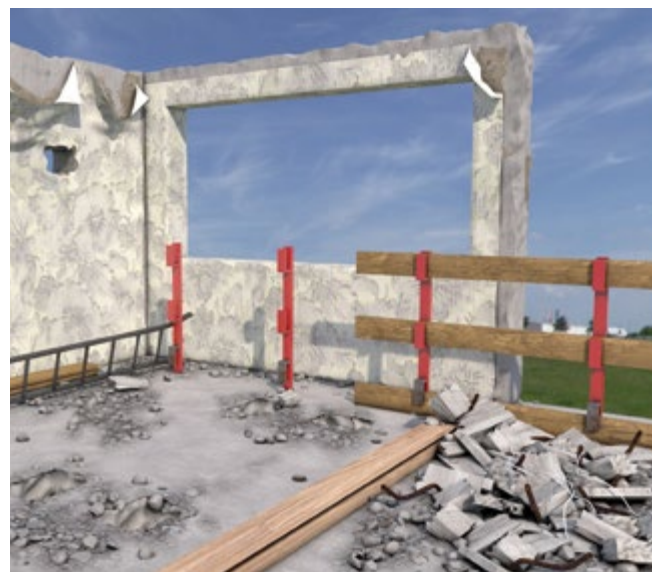
Abb. 111 Absturzsicherung vor der Demontage anbringen
