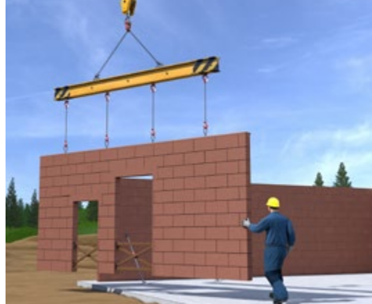
Abb. 113 Angeschlagene Mauertafel mit gesicherten Öffnungen
