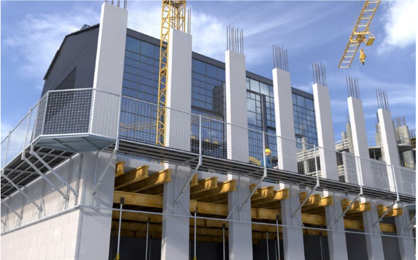
Abb. 122 Konsolgerüst an Stützen-Riegel-Konstruktion
