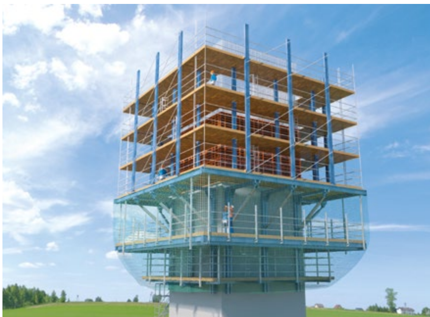
Abb. 54 Kletterschalung an turmartigem Bauwerk
