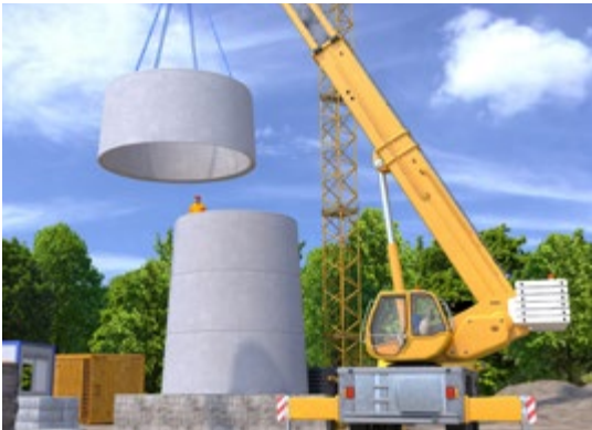
Abb. 140 Montage des Turms einer WEA
