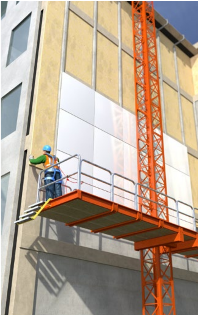
Abb. 126 Montage einer Metallfassade
