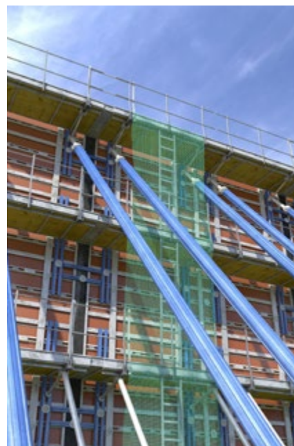
Abb. 55 Wandschalungssystem mit Seitenschutz
