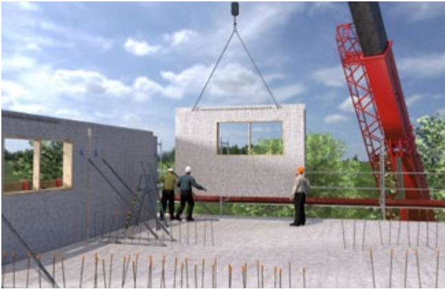
Abb. 109 Montage von Fertigteilen aus Stahlbeton
