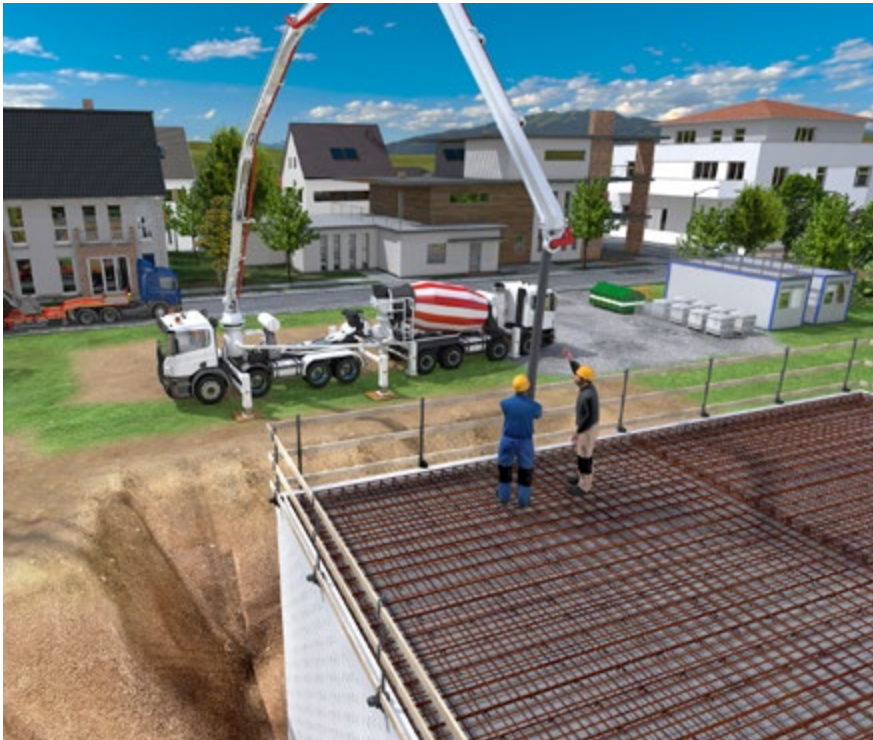
Abb. 105 Einbau von Transportbeton mit Betonpumpe
