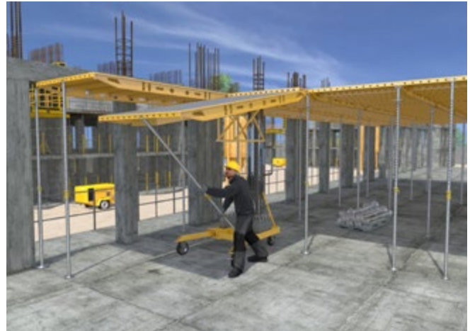
Abb. 119 Montage einer Deckenschalung mit Schalwagen von unten
