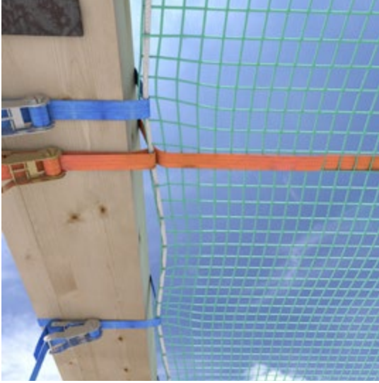
Abb. 63 Spanngurt- Randbefestigung am Holzbalken
