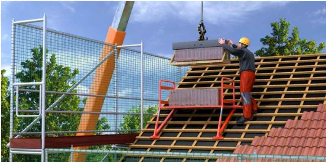
Abb. 137 Ziegelgreifer mit untergehängtem Netz
