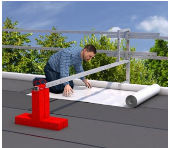
Abb. 135 Absturzsicherung bei Flachdacharbeiten
