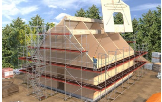
Abb. 110 Montage von Holzbauteilen
