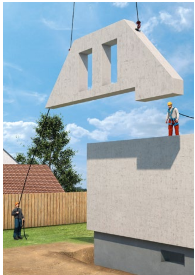
Abb. 84 Verwendung von Leitseilen beim Transport von Fertigteilen
