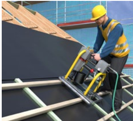
Abb. 31 Einlattergeräte unterstützen das ergonomische Arbeiten
