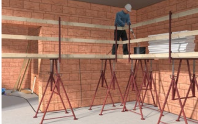
Abb. 100 Bockgerüst
