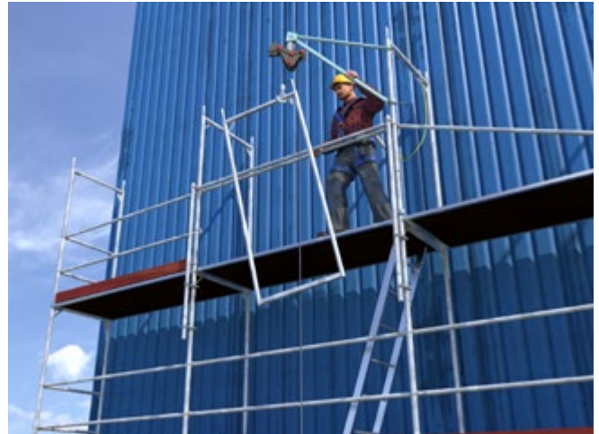
Abb. 117 Ergonomischer Transport von Gerüstbauteilen
