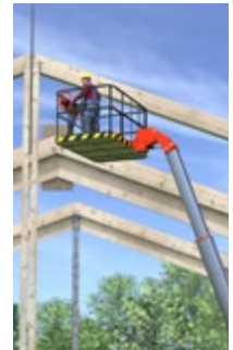
Abb. 131 Montage von Holzbauteilen
