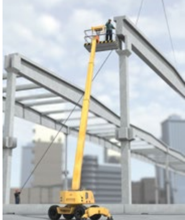
Abb. 111 Sichere Arbeitsplätze bei Montagearbeiten
