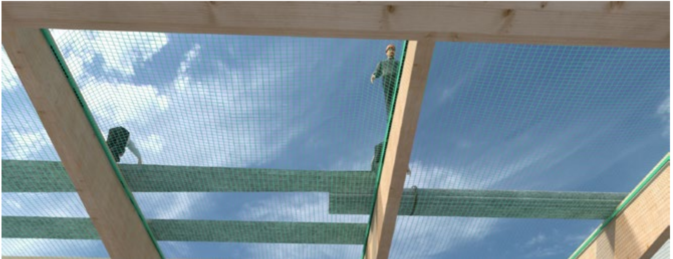
Abb. 58 Schutznetz im Einsatz
