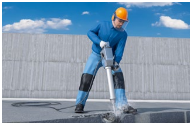
Abb. 40 Stemmarbeiten mit geeigneter PSA
