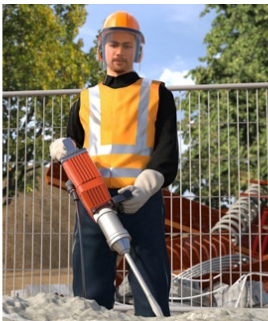
Abb. 26 Persönliche Schutzausrüstung bei Arbeiten mit dem Stemmhammer
