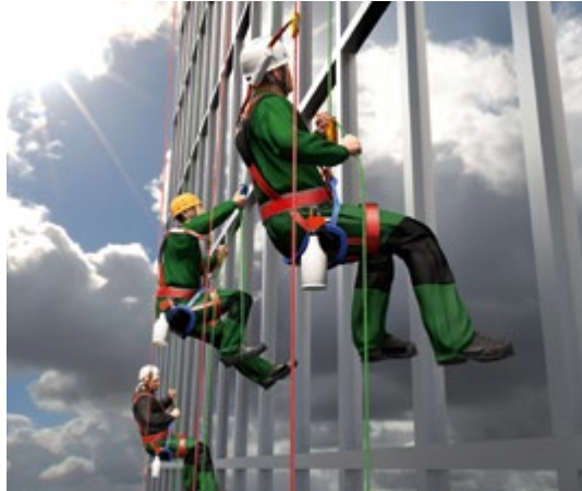
Abb. 145 Endreinigung der Aussenfassade mit SZP
