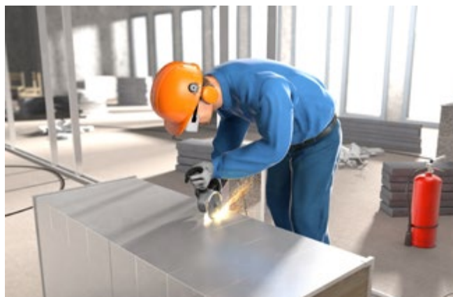
Abb. 28 Persönliche Schutzausrüstung beim Schneiden von Metall
