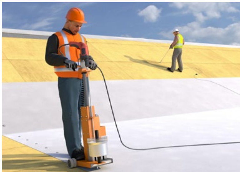
Abb. 139 Ergonomische Verlängerung von Schraubern
