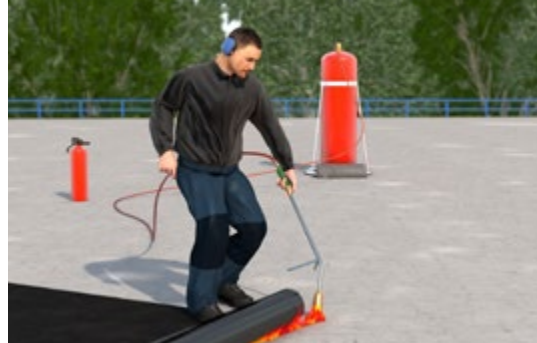
Abb. 21 Dacharbeiten mit Handbrenner
