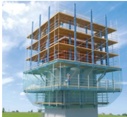
Abb. 141 Kletterschalung an turmartigem Bauwerk
