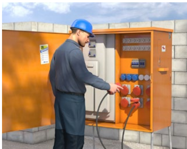
Abb. 17 Verschießbarer Baustromverteiler zur sicheren Stromversorgung einer Baustelle
