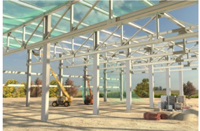
Abb. 57 Montage von Schutznetzen mit Hubarbeitsbühnen
