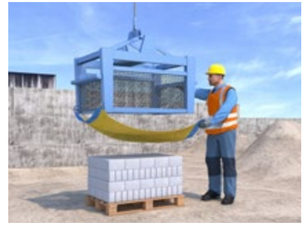
Abb. 99 Steingreifer mit Auffangplane
