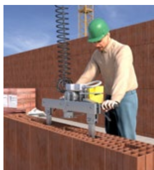
Abb. 102 Versetzhilfe für Mauersteine
