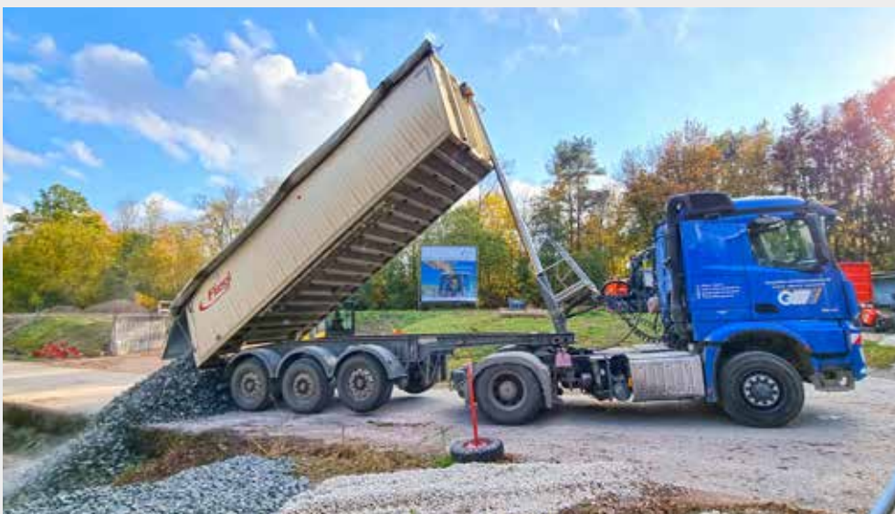
Das Baggergelände der Bayerischen BauAkademie wurde weiter verbessert.
