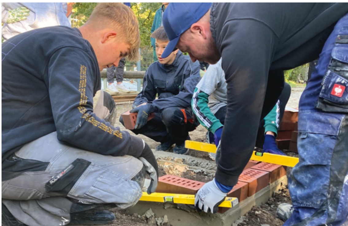
Unter fachkundiger Anleitung des Patenbetriebes (Firma Kaindl) entsteht ein Hochbeet mit SchülerInnen der 9. Klasse an der Mittelschule in Herrsching
