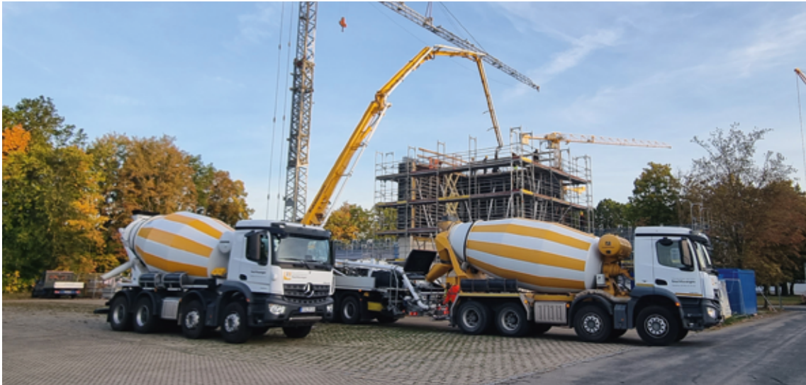
Die Umbauarbeiten an zwei Gebäuden für das neue Praxiszentrum der BG Bau gingen im Jahr 2023 gut voran.
