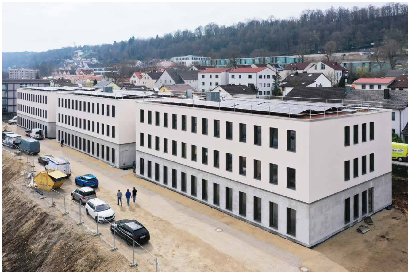
Die extrem effiziente Gebäudetechnik mit Wärmerückgewinnung, Photovoltaikanlagen und einem Retentionsdach ermöglicht einen hohen energetischen Autarkiegrad im neuen Dienstleistungszentrum.
