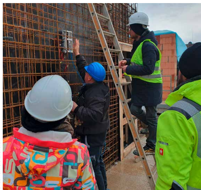
Einbau der Messtechnik in den Wänden mit 100-prozentigem Recyclinganteil für das Monitoring der Hochschule München.
