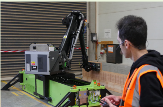
Mauerwerksroboter WLTR zum ersten Mal in Aktion in Deutschland
