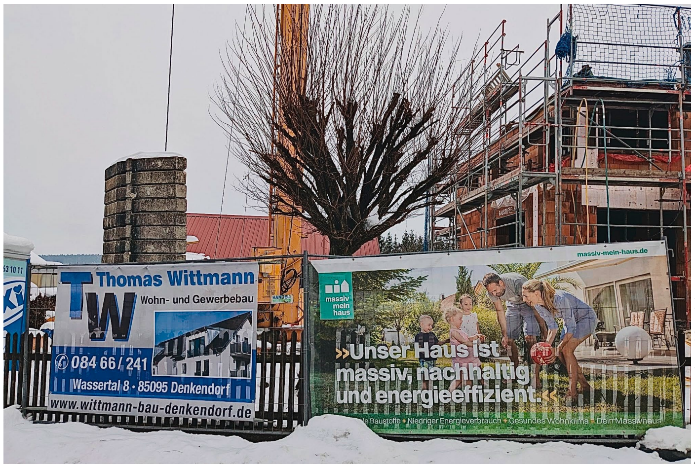
Massivbauwerbung mit dem Bauzaunbanner von Massiv mein Haus auf einer Baustelle in Oberbayern.
