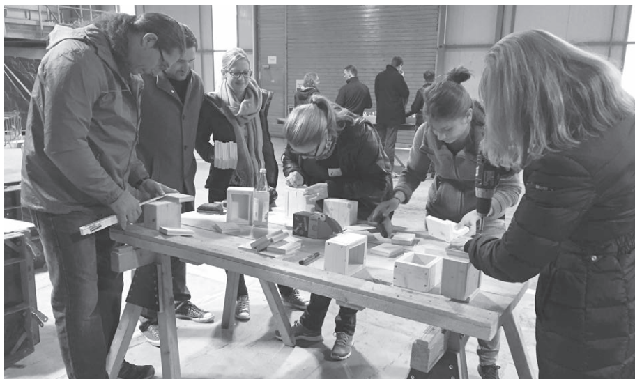
Anschließend wurde beim Bau einer Schalung eifrig gesägt, gehämmert und gefeilt ...
