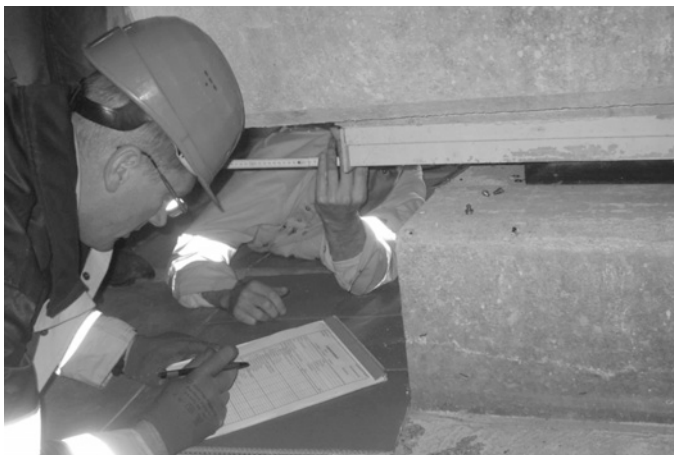
Aufnahme der Bauwerksschäden an der Brückenuntersicht
