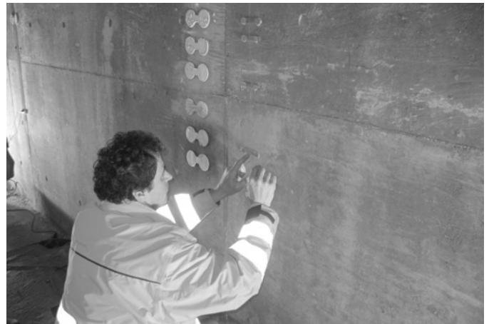
Prüfung der Gleitlagerstärke
