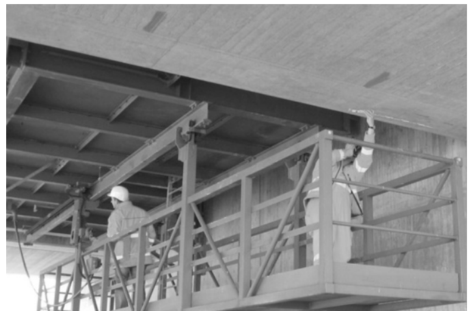
Schadensbegutachtung mittels Hubbühne
