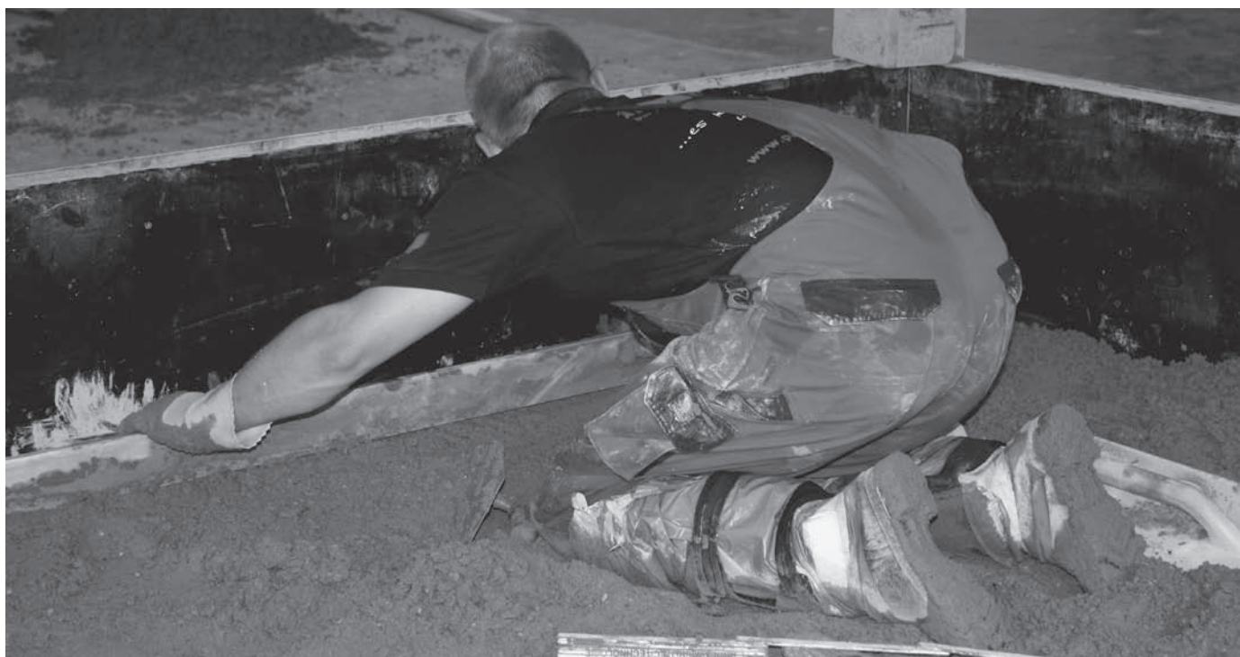
Praxisausbildung in der Bayerischen BauAkademie im Vorbereitungslehrgang zur Meisterprüfung im Estrichlegerhandwerk 2010
